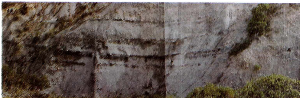
FIGURA 16: Relleno de Canal.
