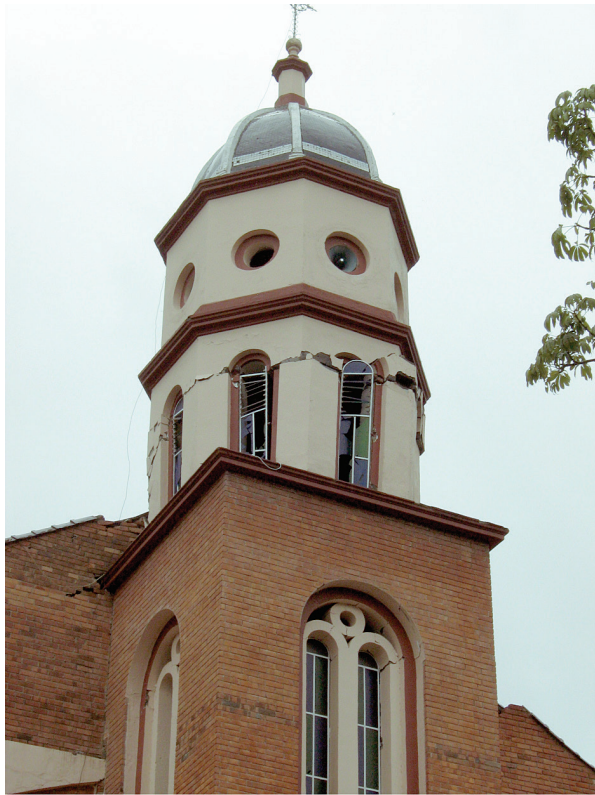
► Figura 1. Grado de afectación de la iglesia de la población de Quetame y de una vivienda como consecuencia del sismo del 24 de mayo de 2008.
