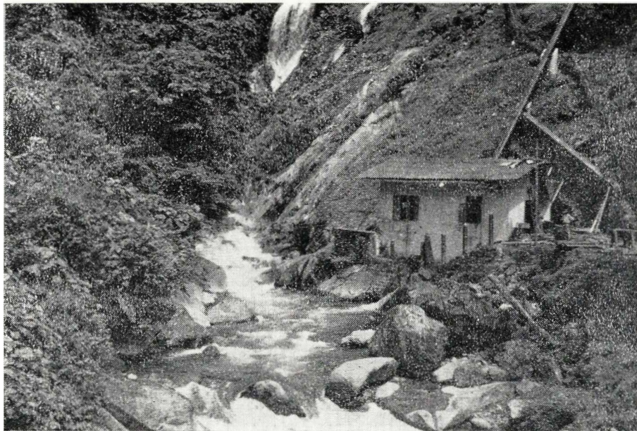
Foto 7.—El río Danubio, cerca de la desembocadura en el río Anchicayá, con planta auxiliar hidroeléctrica.
