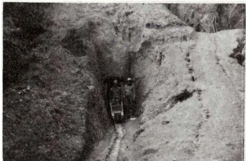
FIG. 13. Entrada a la mina El Coral, municipio San Vicente (238). Nótese el grado de meteorización de la roca ígnea cuarzodiorítica y el rudimentario método de transporte del mineral.
