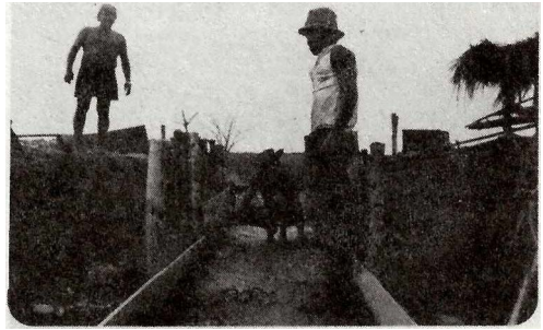
FIG. 30. Canalón de madera para la selección del material lavado con el monitor (método hidráulico), mina Cacerí - Barbería (No. 128).
