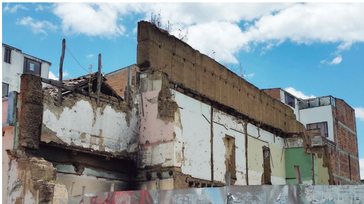
Figura 12. Mezcla de materiales en muros de viviendas en Pasto Fuente: Archivo personal. Sarabia (2017)
