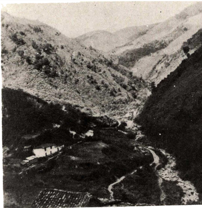
Fig. 1.- El valle del río La Baja a la altura de San Antonio, mirando hacia el NE o sea aguas arriba.
