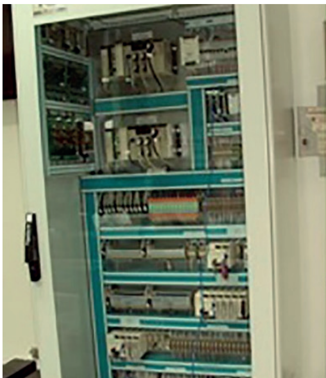
Figura 8. Gabinete de instrumentos. Fuente: [20]
